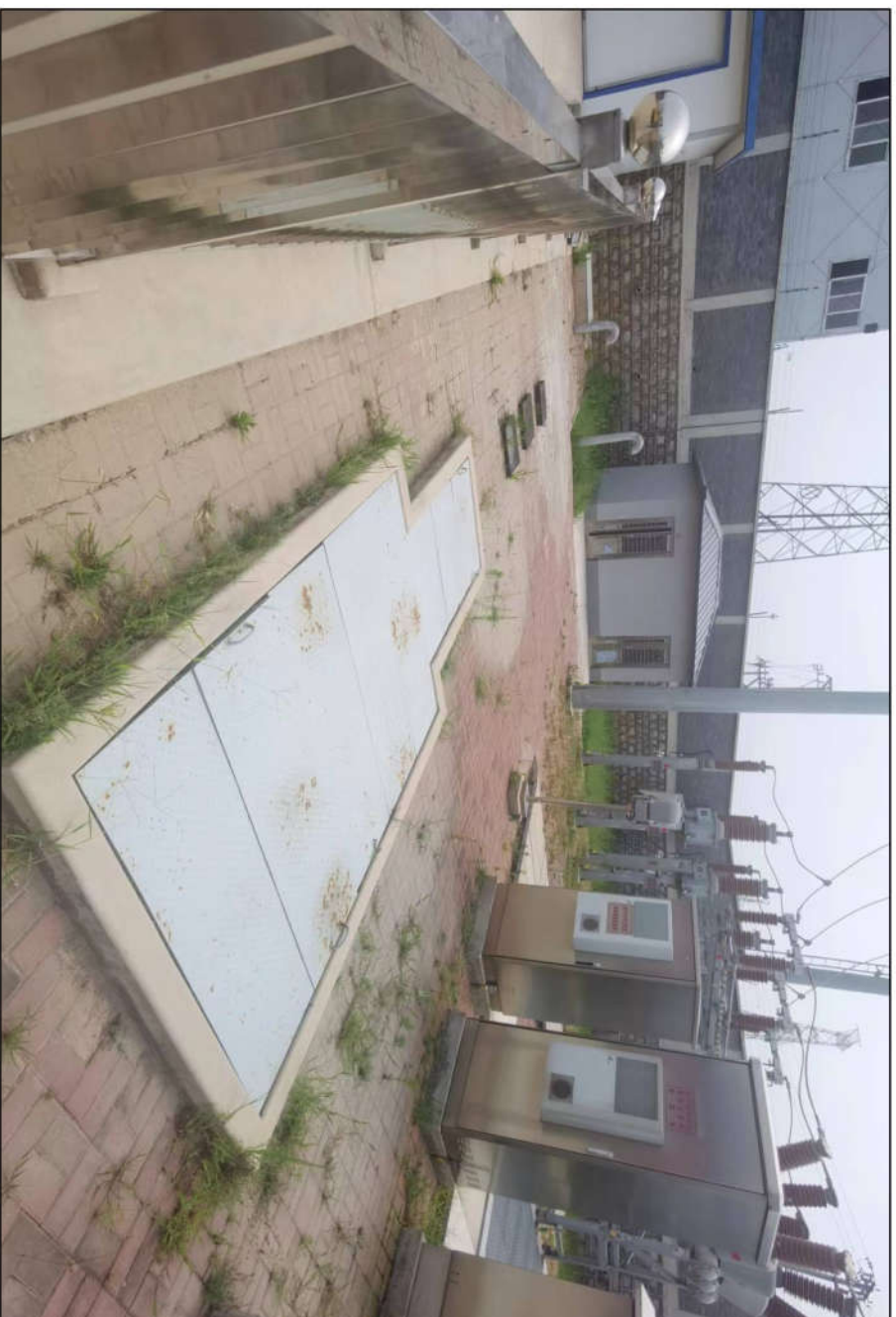
地埋式污水处理装置（前期已建）
